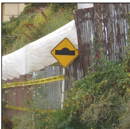
UNIDAD DE SEÑALIZACION EN POSTE: GIBA
