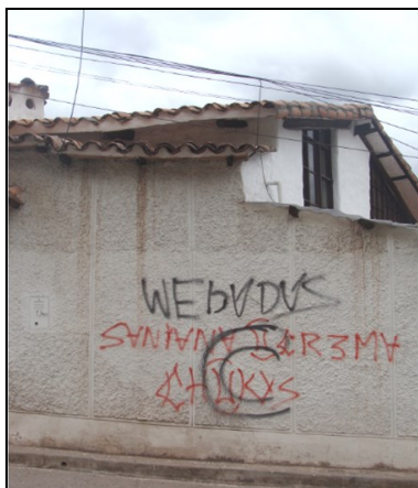
CONTAMINACION VISUAL EN MUROS: SECTOR 7
