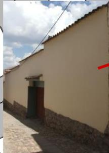
MAMPOSTERIA DE LADRILLO, ESTRUCTURA DE CONCRETO, ENLUCIDO DE CEMENTO, ZOCALO DE ENCHAPE DE PIEDRA.
