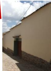
TEXTURA RUGOSA DEL MURO BLANQUEADO CON YESO, TEXTURA ASPERA DEL ZOCALO EMBOQUILLADO DE PIEDRA
