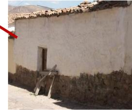
TEXTURA RUGOSA DEL MURO BLANQUEADO CON YESO, TEXTURA ASPERA DEL ZOCALO EMBOQUILLADO DE PIEDRA
