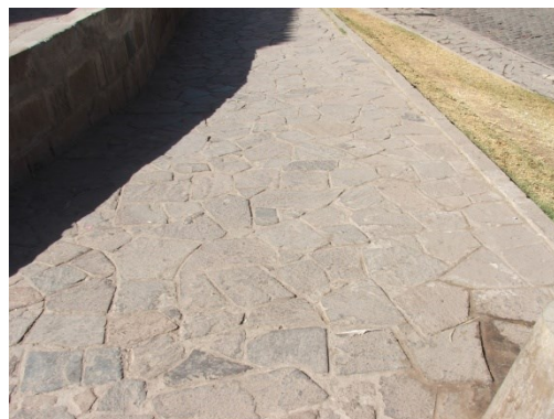
PISO CON LAJAS IRREGULARES DE PIEDRA
