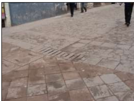
Sumideros de concreto de recolección de aguas pluviales.
