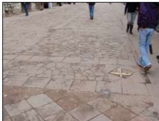
Piso de loseta de piedra, de aproximadamente de 0.30X0.30cm.
