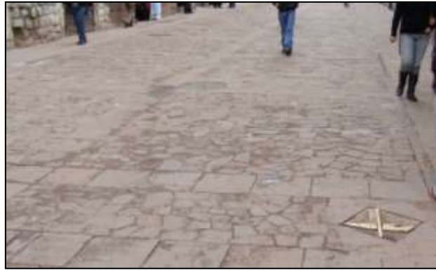
VÍA PEATONAL CON ACABADO DE LAJAS REGULARES DE PIEDRA.
