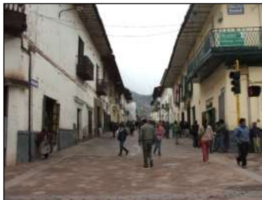
Existencia de instalaciones de cableado aérea, ocasiona contaminación visual, además de distorsionar el paisaje urbano.
