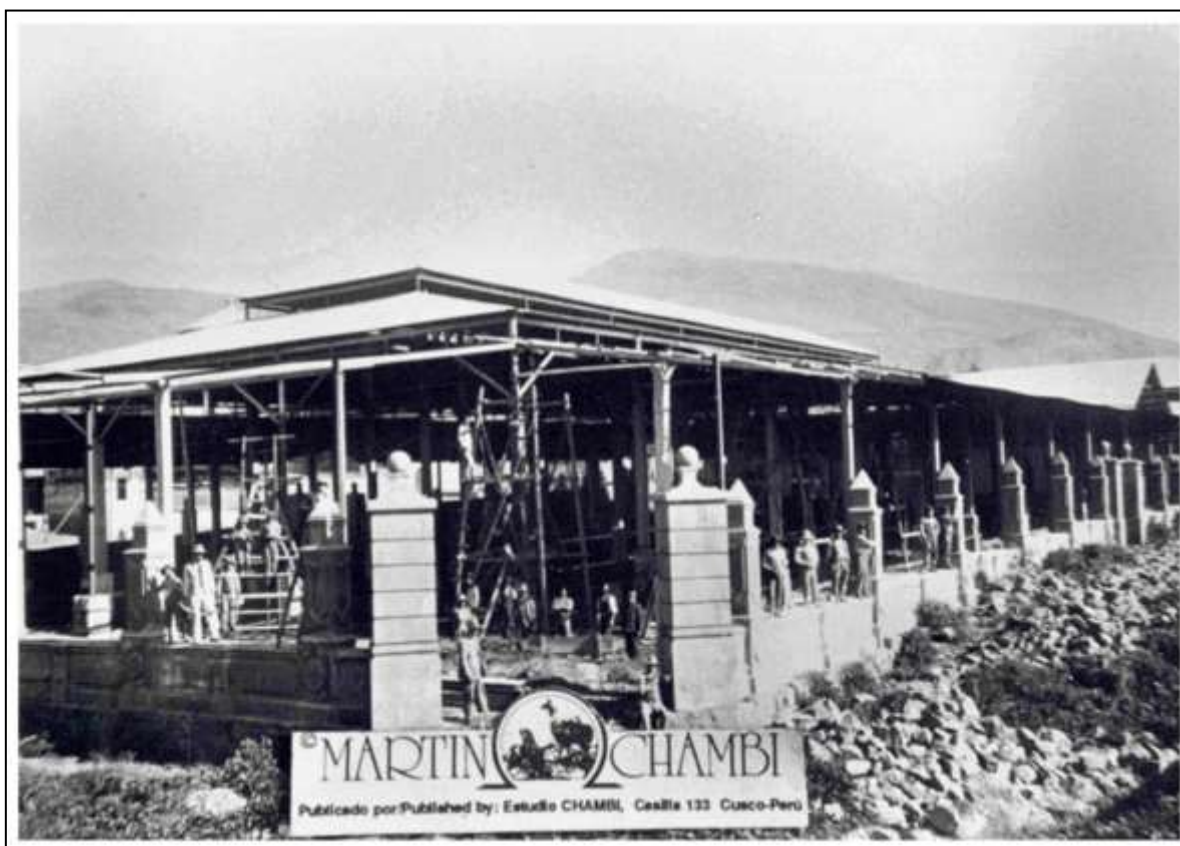
Edificación del Mercado Central de Abastos de la Ciudad del Cusco, el cual cambio la fisonomía urbana y económica del barrio de San Pedro.
