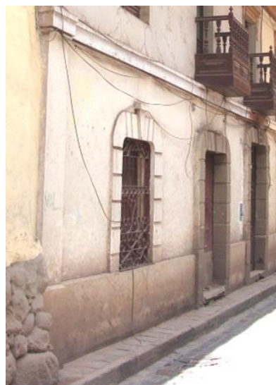
Sector 2: vereda fachada Norte
