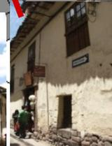
MAMPOSTERIA DE LADRILLO, ESTRUCTURA DE CONCRETO, ZÓCALO DE PIEDRA ORDINARIA IRREGULAR EMBOQUILLADA, APAREJO POLIGONAL CARAVISTA
