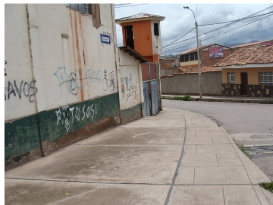
VEREDAS DE CONCRETO
