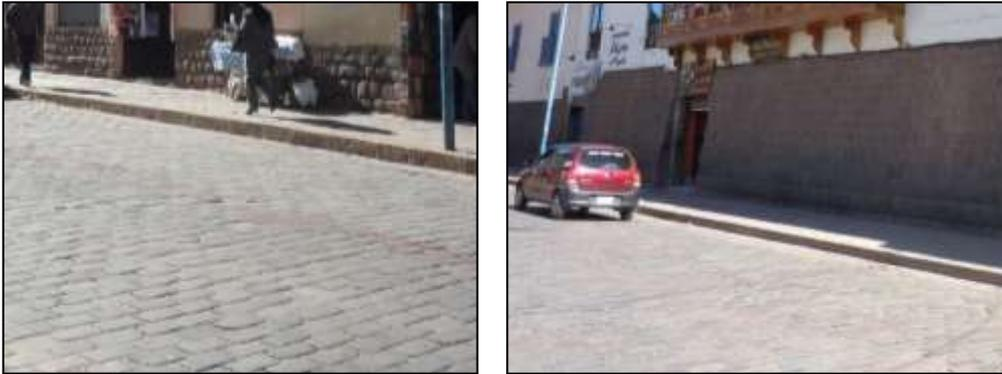
CALZADA COMPUESTA POR ADOQUINES DE PIEDRA.
