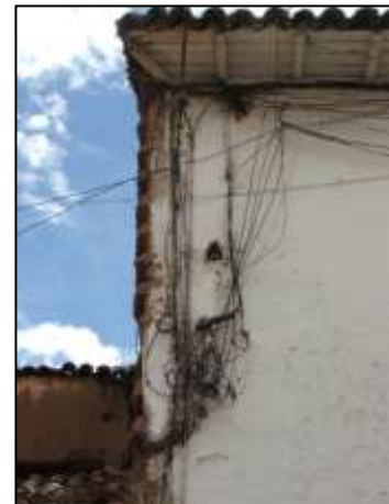
INSTALACIONES ELECTRICAS ARBITRARIAS E IMPROVISADAS
