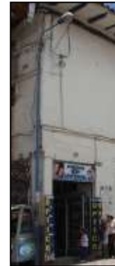
POSTE DE ILUMINACIÓN
