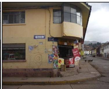
SEÑALIZACION DE CIRCULACION DE DOBLE SENTIDO EN MURO
