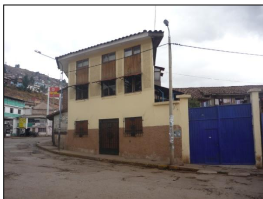
POSTE DE ILUMINACION
