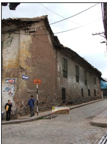
VISTA DE CALLE NUEVA ALTA
