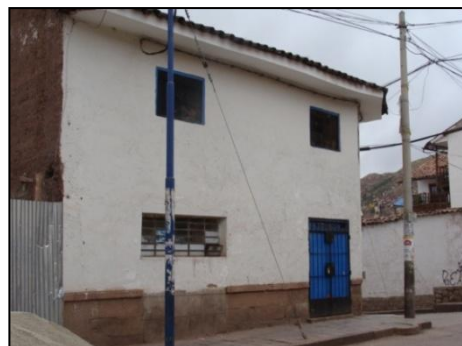
POSTE SOPORTE DE CABLEADO
