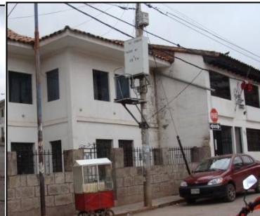
SEÑALIZACION EN POSTE
