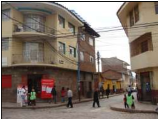
CONTAMINACIÓN VISUAL POR CABLEADO AÉREO.
