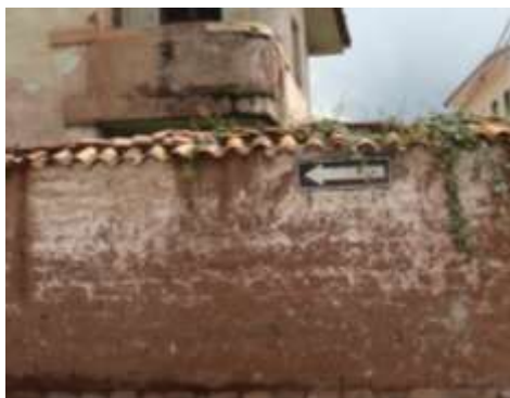
SEÑALIZACION EN LA ESQUINA CON LA CALLE LECHUGAL
