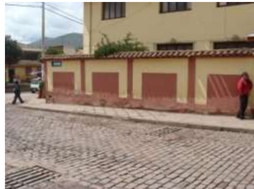
A LOS LADOS DE LA CALZADA SE PUEDE APRECIAR EL TRATAMIENTO CON CANTRO RODADO.
