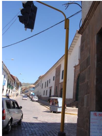
SEMAFORO VEHICULAR EN ESQUINA CON CALLE TEATRO.
