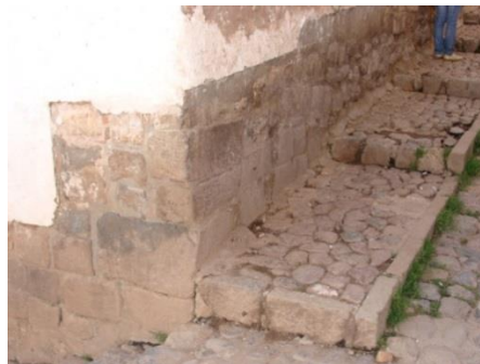
Sector 2: vereda fachada Sur-oeste
