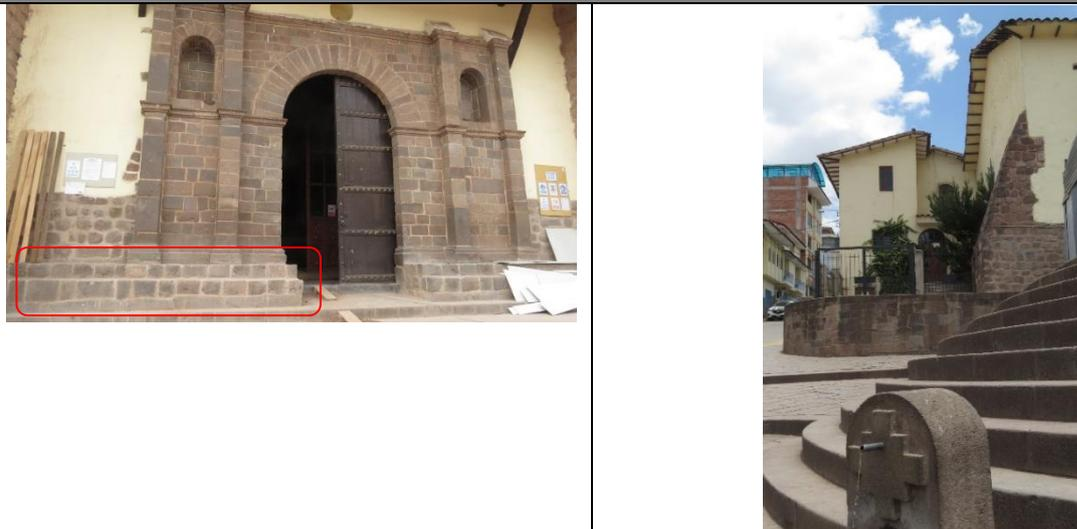
**Evidencia 03:** se identificó elementos líticos reutilizados de factura pre hispánica, ubicados en las gradas, contrafuertes y sobrecimiento de la cara frontal del templo de Santiago.
