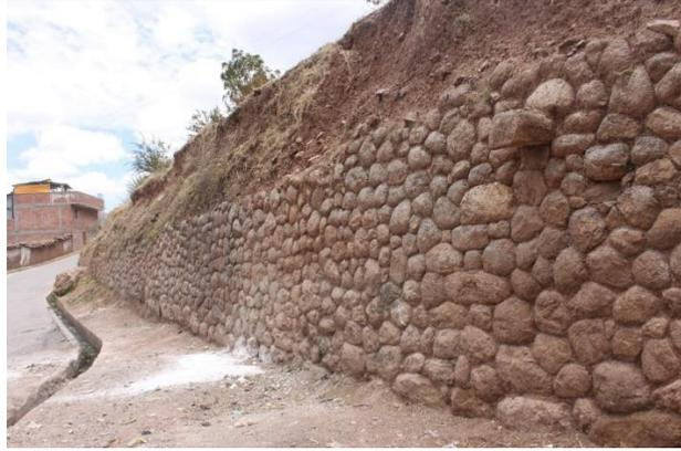
*Muro de contención, de mampuesto fino aparejo celular, con material lítico de tipo caliza y mortero de barro. Presenta intervención, conserva parte del muro original y su traza original prehispánico.*
