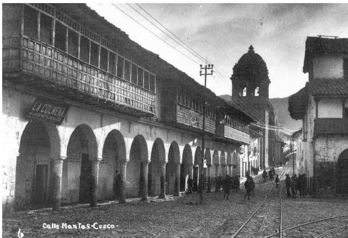
PORTAL DE LA COMPAÑÍA, AL FONDO EL TEMPLO DE LA MERCED, TAMBIÉN PODEMOS OBSERVAR QUE HACIA MANTAS NO EXISTIAN LOS ACTUALES PORTALES
