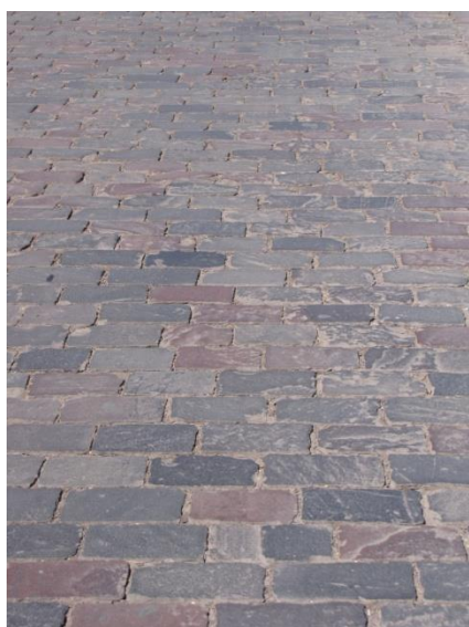
PAVIMENTO DE LA CALZADA PERIMETRAL, ADOQUINES DE PIEDRA
