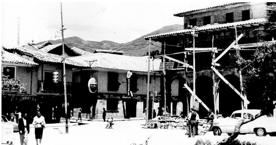
CONSTRUCCIÓN DE UNA NUEVA EDIFICACIÓN EN ESTILO NEOCOLONIAL EN LA ESQUINA DEL PORTAL DE PANES Y CALLE PLATEROS
