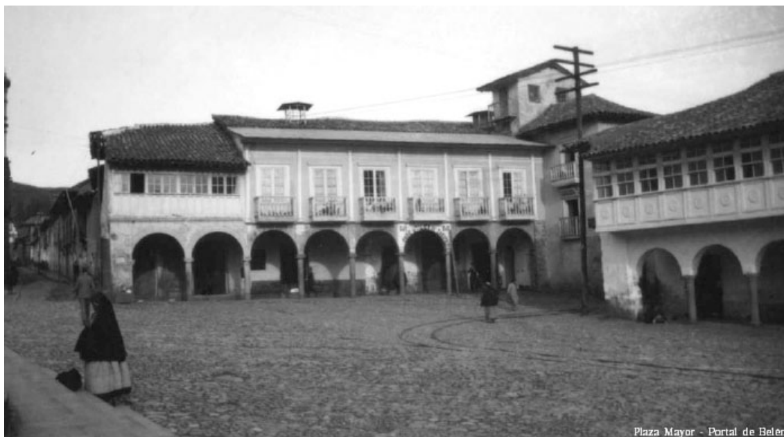
Plaza Mayor - Portal de Belén PORTALES DE BELÉN Y PARTE DEL PORTAL DE CARRIZOS, IMAGEN DE 1940 69
