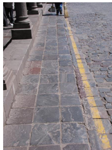
PORTAL DE LA COMPAÑÍA, VEREDA EXTERIOR
