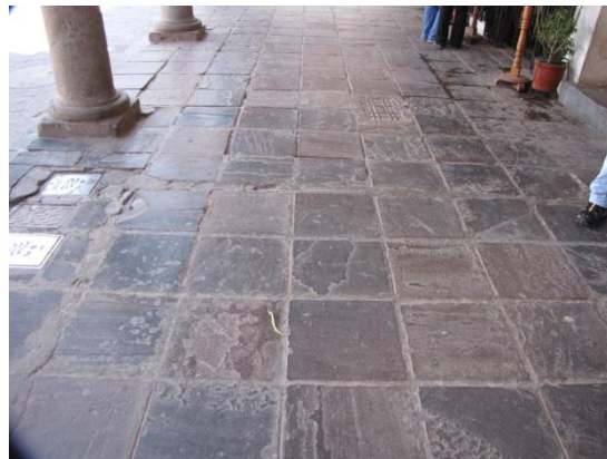
PORTAL DE BELEN, LOSETAS REGULARES
