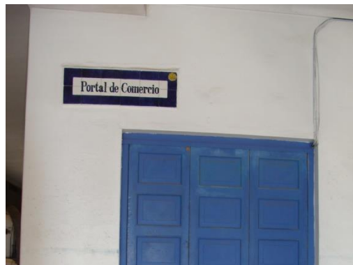
SEÑALIZACIÓN EN MURO
