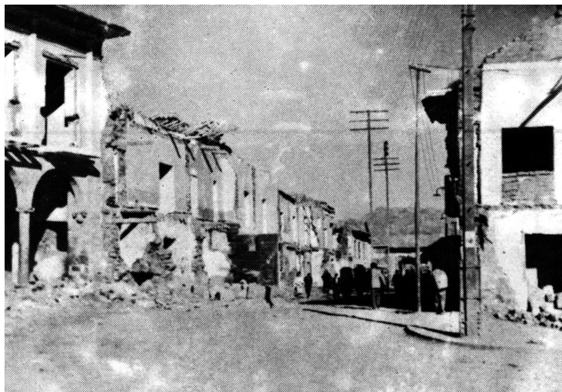
DEMOLICION DE VIVIENDAS EN LA CALLE SANTA CATALINA ANGOSTA CON PROPÓSITOS DE ENSANCHAMIENTO
