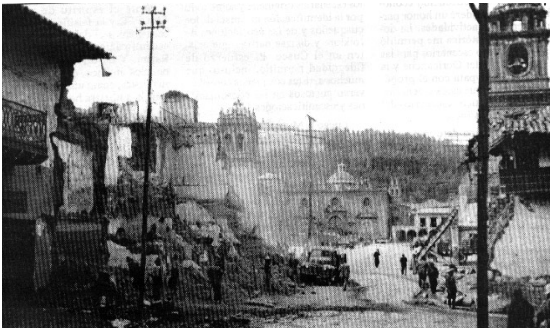
DEMOLICIÓN DEL PARANINFO UNIVERITARIO Y CALLE MANTAS
