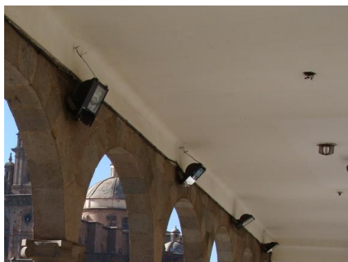
REFLECTORES PARA LA ILUMINACIÓN INTERIOR.
