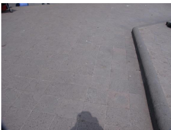
PISO PLATAFORMA DE LA PILETA: LAJA REGULAR.
