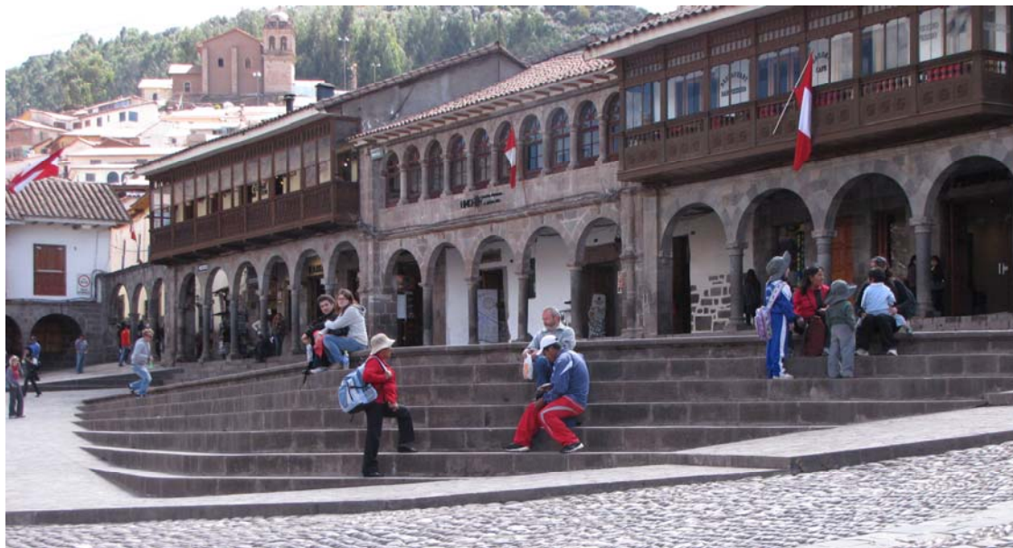
EL "FALSO ATRIO" CONSTRUIDO POR EL ALCALDE SALIZAR
