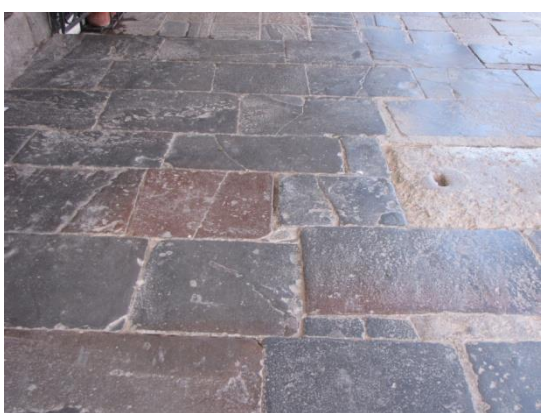
PORTAL DE BELEN, LOSETAS REGULARES DE GRAN TAMAÑO
