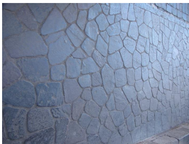
VEREDAS CON LAJAS IRREGULARES DE PIEDRA
