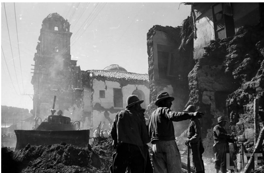
DEMOLICIÓN DEL PARANINFO UNIVERSITARIO Y EL PORTAL DE LA COMPAÑÍA
