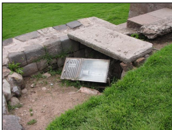
UNIDAD DE LUMINARIA EN PISO
