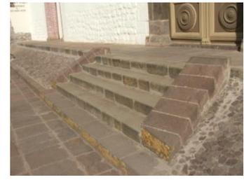
DIFERENTES TIPOS DE PAVIMENTO: CALZADA DE ADOQUINES REGULARES DE PIEDRA, COLOCADOS EN APAREJO ISÓDOMO, JUNTAS SELLADAS CON ASFALTO. PAVIMENTO DE LOSETAS DE PIEDRA DE DIMENSIONES GRANDES, VEREDAS DE LOSETAS REGULARES, PIEDRA DE CANTO RODADO EMBEBIDOS EN MEZCLA DE CONCRETO EN EL SECTOR UTILIZADO COMO ESTACIONAMIENTO.
