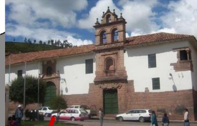
MAMPOSTERIA DEL PRIMER NIVEL DE PIEDRA LABRADA, DE LOS NIVELES SUPERIORES DE LADRILLO, ESTRUCTURA DE CONCRETO, ENLUCIDO DE ESTUCO DE YESO.
