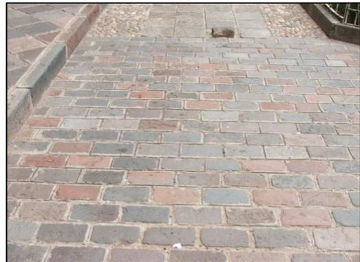
Calzada con adoquines regulares de piedra, colocados en aparejo isódomo, juntas selladas con asfalto.
