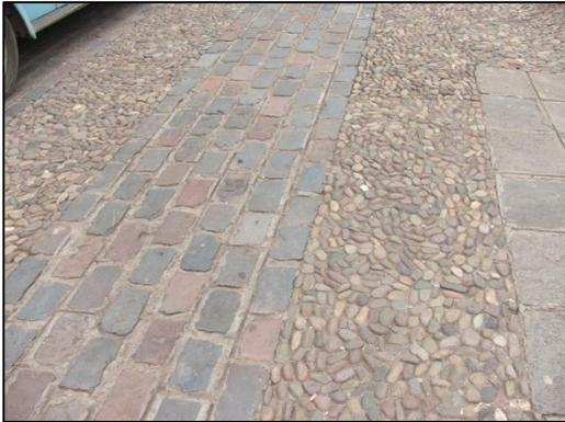
Calzada con dos tipos de material, adoquines regulares de piedra, colocados en aparejo isódomo, juntas selladas con asfalto; y canto rodado embebido en mezcla de concreto.
