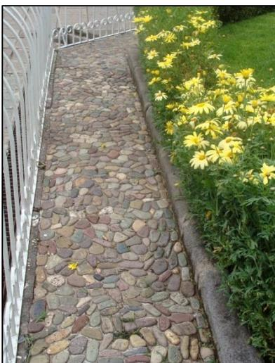
Tratamiento del piso de la pileta con canto rodado embebido con concreto.
