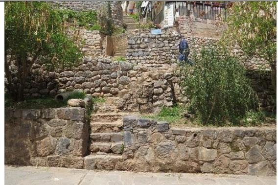
*Muro de retención de factura original edificada con elementos líticos de caliza y en baja proporción diorita y andesita. Presenta un aparejo de tipo celular unidos con mortero de barro.*
