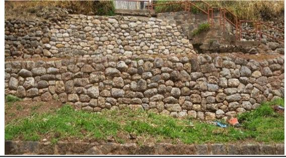
*Muro de contención, de mampuesto fino aparejo celular, con material lítico de tipo caliza y mortero de barro. Presenta intervención, conserva parte del muro original y su traza original prehispánico.*
