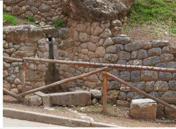
*Se muestra una sección de muro edificado con elementos líticos de caliza de diversas dimensiones unidos con mortero de barro, presenta un aparejo de tipo celular.*
