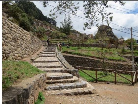
*Escalinata principal de piedra de aparejo irregular- y canal de evacuación de aguas pluviales a un costado.*
