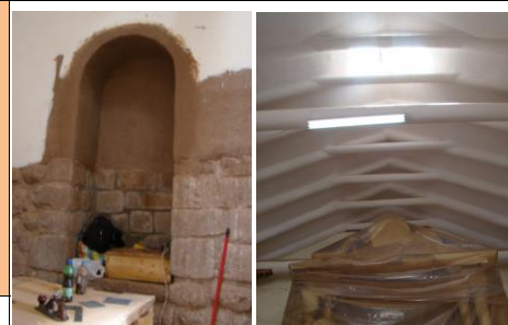
HORNACINA EN ARCO DE MEDIO PUNTO CUBIERTA EN PAR Y NUDILLO
