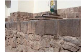
M06 DETALLE DE MURO DE CONTENCIÓN
