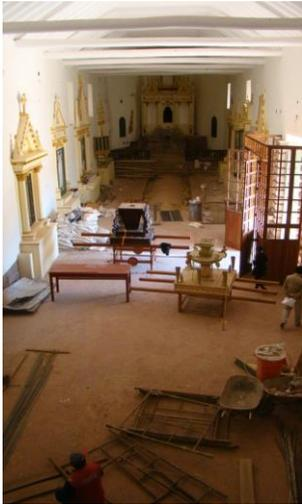
PLANTA RECTANGULAR DE TRAZO SIMPLE Y OCHAVADA EN EL ABSIDE, PRESENTA UNA SOLA NAVE CON ESTRUCTURA EN EL TECHO DE PAR Y NUDILLO Y TIRANTE, LA NAVE ORIGINAL DE LONGITUD MAS CORTA, ACTUALMENTE AMPLIADA, HACIA EL AREA QUE CORRESPONDE AL CORO Y SOTOCORO.
