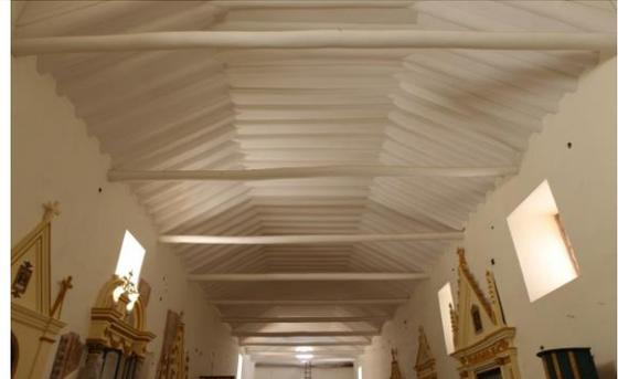
F717 CUBIERTA DE LA NAVE: EN ARTESA CON ESTRUCTURA DE PAR Y NUDILLO Y TIRANTE
