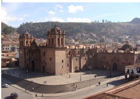
F11 VISTA PANORAMICA DEL CONJUNTO CATEDRALICIO
