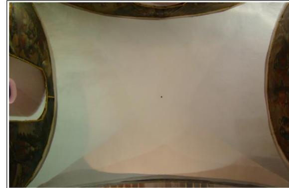
F86 VISTA DE LA CUBIERTA, CONSTITUIDA POR DOS BOVEDAS VAIDAS.
