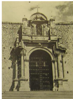
Portada lateral de la nave totalmente restaurada (Fuente: Junta de Reconstrucción y Fomento Industrial del Cuzco. Años.1952-1953)
