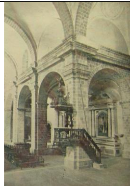
Pulpito, columnas y bóveda restauradas. (Fuente: Junta de Reconstrucción y Fomento Industrial del Cuzco. Años.1952-1953)
