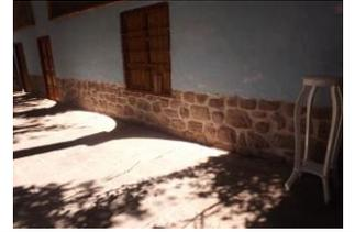
M32 DETALLE DEL SOBRECIMIENTO CON ALGUNOS LITOS DE FACTURA INCA REUTILIZADOS DE MATERIAL CALIZA
