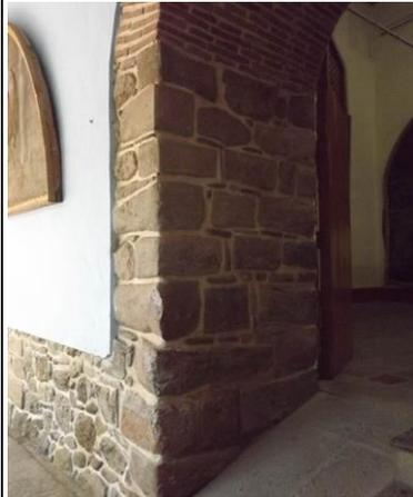
M34 DETALLE DEL CHIFLÓN CON LITOS DE FACTURA INCA REUTILIZADOS
