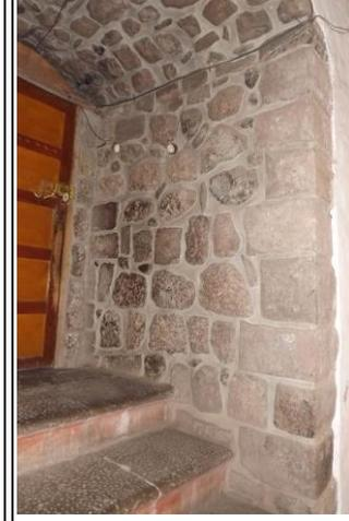
M38 DETALLE DE MURO LATERAL CON LITOS DE FACTURA INCA REUTILIZADOS
