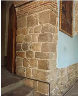
M35 DETALLE DEL CHIFLÓN CON LITOS DE FACTURA INCA REUTILIZADOS
