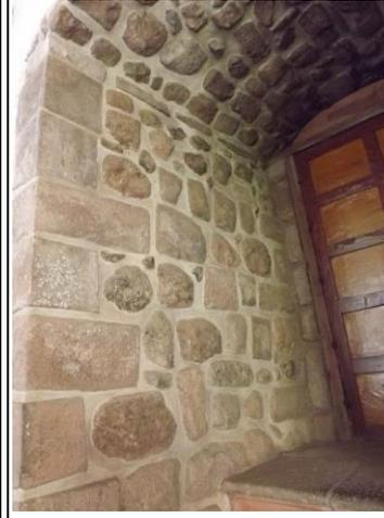
M37 DETALLE DE MURO CON LITOS DE FACTURA INCA REUTILIZADOS
