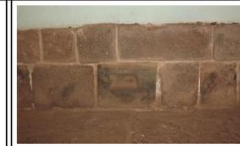
M45 DETALLE DEL SOBRECIMIENTO-LITOS DE MATERIAL ANDESITA
