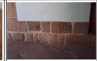
M47 DETALLE DEL SOBRECIMIENTO CON LITOS DE MATERIAL ANDESITA CON LA PRESENCIA DE UN PETROGLIFO
