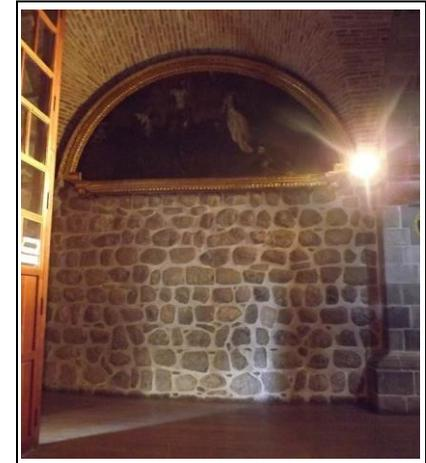
M54 DETALLE DE MURO CON LITOS DE FACTURA INCA REUTILIZADOS
