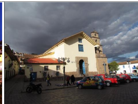
F15 VISTA DE FACHADA-CALLE CARMEN BAJO
