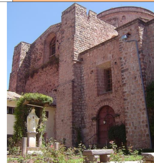
F12 VISTA DE FACHADA POSTERIOR-MURO TESTERO-PORTADA POSTERIOR DESDE SACRISTIA
