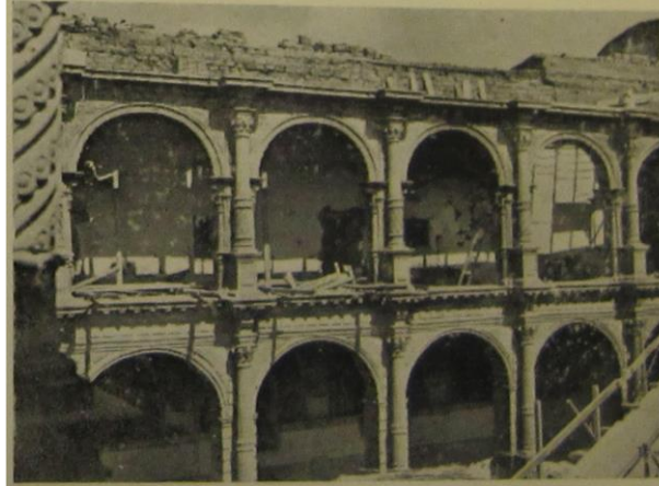
Vista del claustro en plena obra de restauracion.
