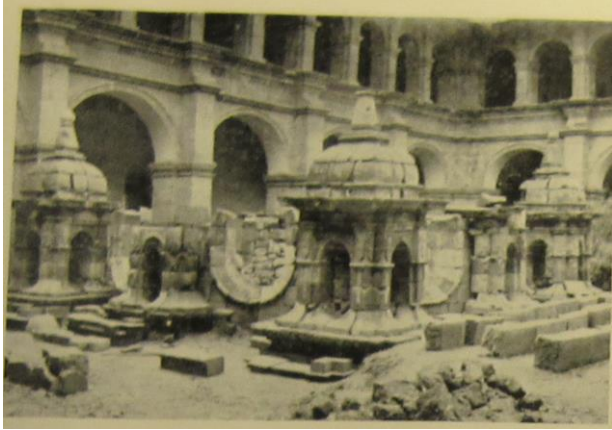
Capulines, Cimborio y Cornizas de Arranque de la Torre de la Merced presentados en el segundo Claustro despues del Sismo.
