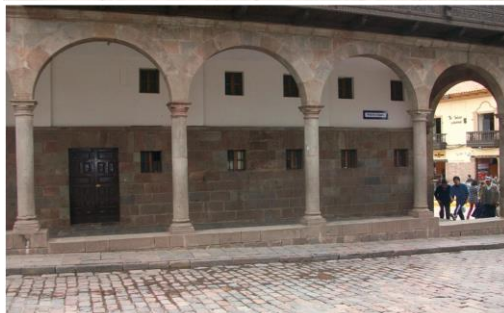
F15 BALCON DE CAJON DE ESTILO BARROCO, Y GALERIAS DEL PORTAL MANTAS CON ARCOS DE MEDIO PUNTO SOSTENIDAS POR COLUMNAS DE
