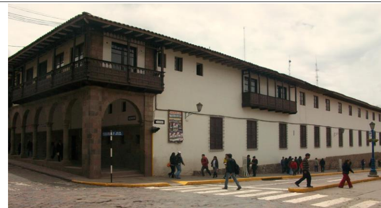
F14 FACHADA HACIA LA AV. SOL, SIGUE LA INCLINACION DE LA VIA MOSTRANDO UN SOTANO.
