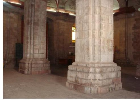
EL VESTIBULO DE PLANTA REGULAR ESTÁ ESTRUCTURADO POR CUATRO COLUMNAS GRUESAS Y SOLIDAS QUE SOSTIENEN ARCOS FORMEROS QUE FORMAN LA CUBIERTA DE BOVEDA AGALLONADA, EN EL AREA CENTRAL EXISTE TODO EL CONJUNTO DEL CIMBORRIO Y LA BOVEDA VAIDA APOYADA SOBRE UN FRISO QUE SE REMATA CON CON UNA LINTERNA CENTRAL. CONTIENE UNA PORTADA QUE ACCEDER AL INTERIOR DEL CLAUSTRO.
