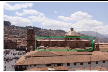
M09 E.M2: MUROS Y CONTRAFUERTE LATERALES DE LA COMPAÑIA DE JESUS
