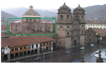
M05 E.M2: MUROS Y CONTRAFUERTE LATERALES DE LA COMPAÑIA DE JESUS
