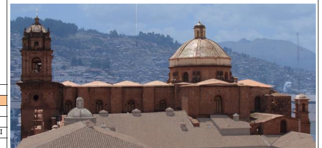
F18 MURO DE LA EPISTOLA O MURO LATERAL DERECHO - PARTE EXTERNA DEL CLARISTOR
