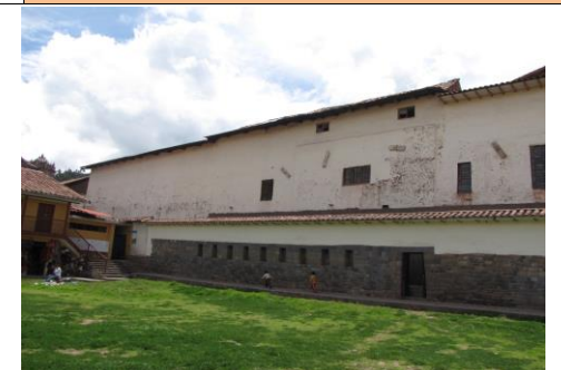
F110 VISTA FACHADA POSTERIOR DEL PRIMER CLAUSTRO-CALLE LORETO
