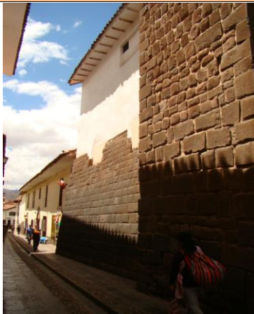
F12 FOTO DE FACHADA NORESTE HACIA LA CALLE AREQUIPA
