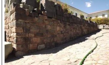
M159 DETALLE DE MURO CON LITOS DE FACTURA INCA REUTILIZADOS
