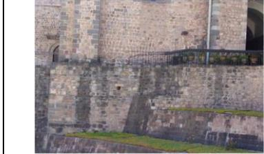
M164 VISTA DE MURO CON LITOS DE FACTURA INCA REUTILIZADOS
