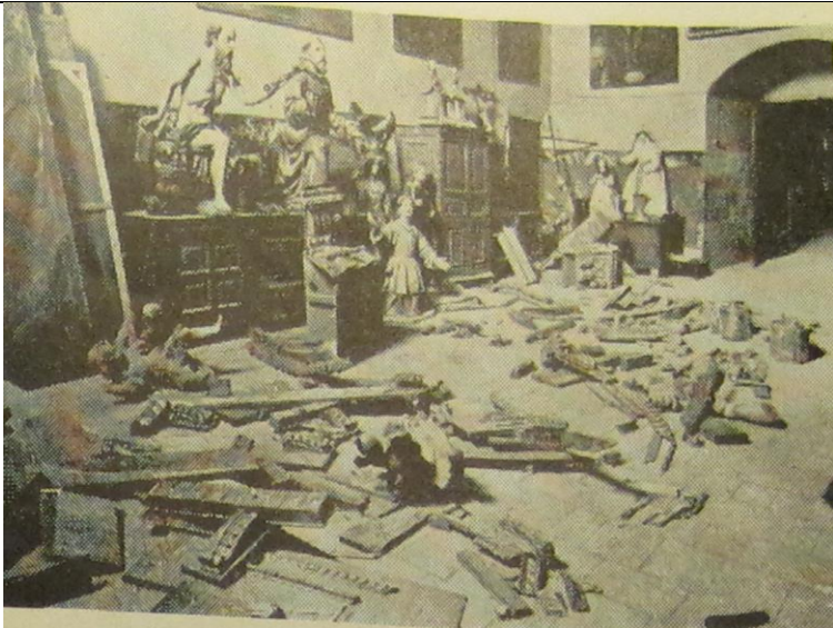
Diferentes aspectos del retablo mayor después del sismo.
