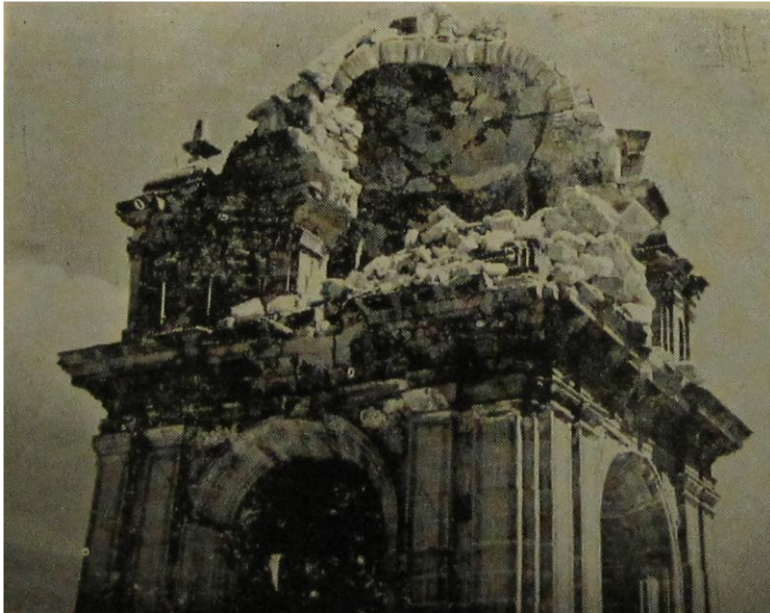
Torre de la epístola después del Sismo.
