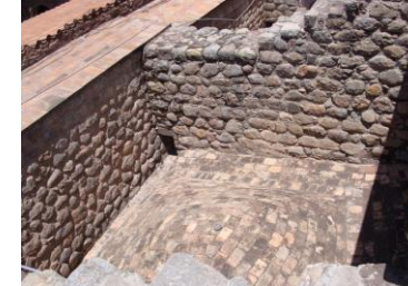
F612 BOVEDA ENTRE CONTRAFUERTESESCALONADOS
