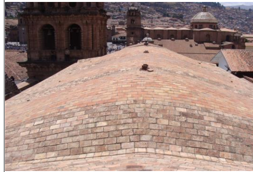
F63 VISTA GENERAL HACIA EL MURO DE PIES
