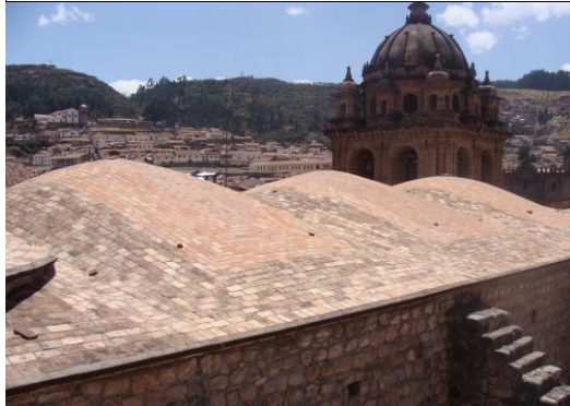
F62 VISTA DE CONJUNTO DE LA CUBIERTA
