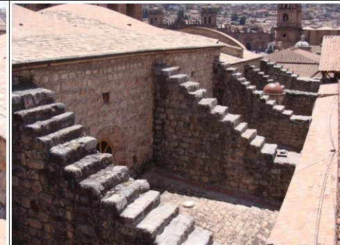
F68 CONTRAFUERTESESCALONADOS UBICADOS SOBRE LA CUBIERTA DE LA NAVE DEL EVANGELIO
