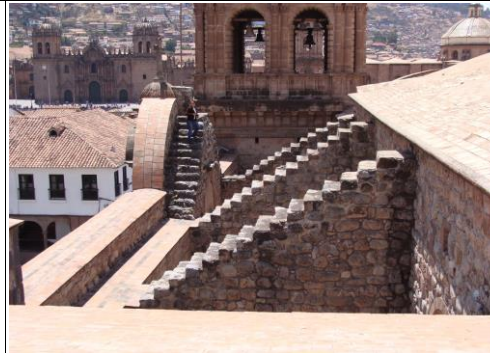
F67 CONTRAFUERTESESCALONADOS UBICADOS EN LA CUBIERTA DE LA NAVE DE LA EPISTOLA
