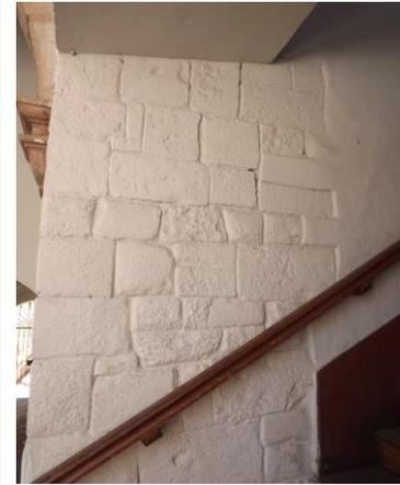
M35 DETALLE DEL MURO CON ALGUNOS LITOS DE FACTURA INCA REUTILIZADOS REVESTIDO CON PINTURA BLANCA
