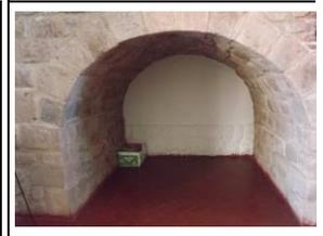
M43 DETALLE DE MURO DE CONTENCIÓN DE LA ESCALERA TABICADA
