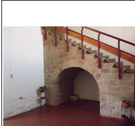
M40 E.M.8: SOBRECIMIENTO DEL 2° CLAUSTRO Y MURO DE CONTENCIÓN DE ESCALERA TABICADA CON ALGUNOS LITOS DE FACTURA INCA REUTILIZADOS
