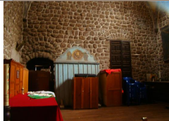
F83 VISTA DE MURO TESTERO DE LA SACRISTIA. DETALLE: MOBILIARIO
