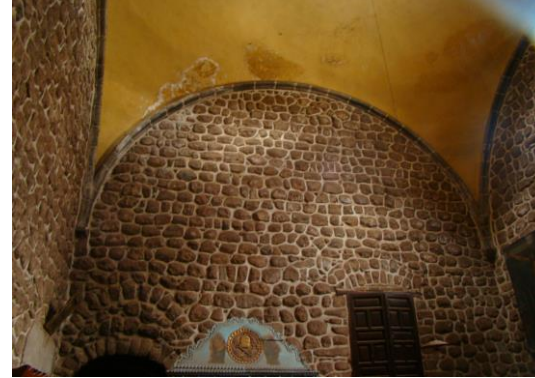
F82 VISTA DE PAÑO DE MURO Y ARRANQUE DE CUBIERTA.
