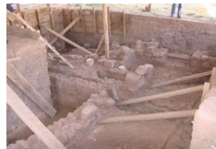
M51 CIMIENTOS DEL TEMPLO ORIGINAL DE SANTA ANA, RECUPERADOS EN EXCAVACIONES ARQUEOLOGICAS
