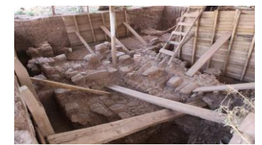
M52 CIMIENTOS DEL TEMPLO ORIGINAL DE SANTA ANA, RECUPERADOS EN EXCAVACIONES ARQUEOLOGICAS
